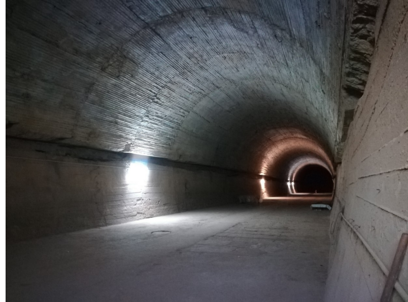
Predappio Bunker Emilia Romagna Overburden ~50-70 m
